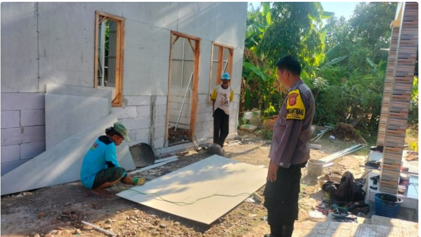
Bhabinkamtibmas Polsek Terisi Monitoring Pembangunan Rutilahu Dari Kapolres Indramayu.
