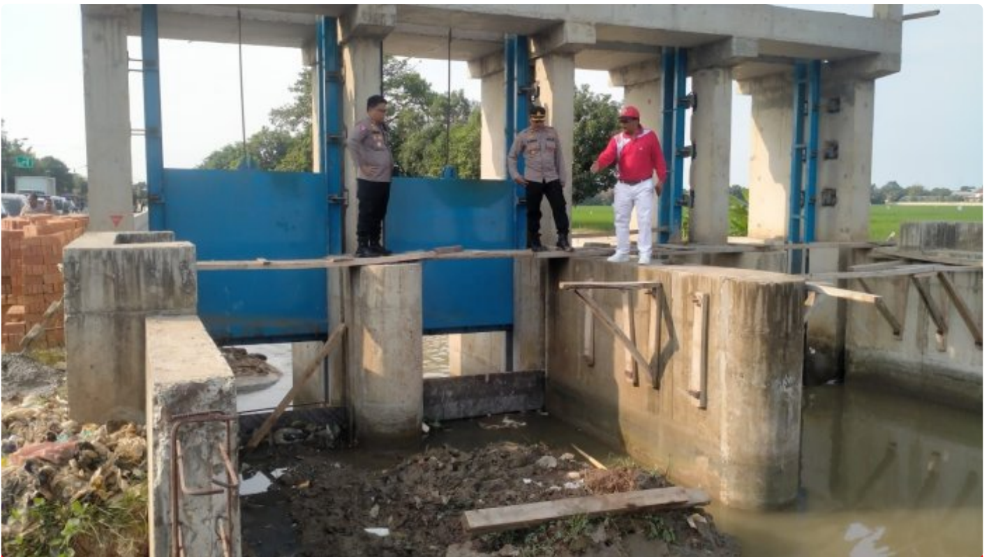
Kapolres Indramayu dan Pejabat Polres Lakukan Pengecekan Pintu Air di Kecamatan Lohbener
